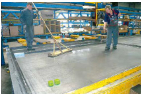
Fig. 4.1. Påføring af formolie
