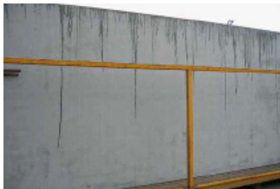
Fig. 5.4 Ubeskyttet oplagring: vandspor
