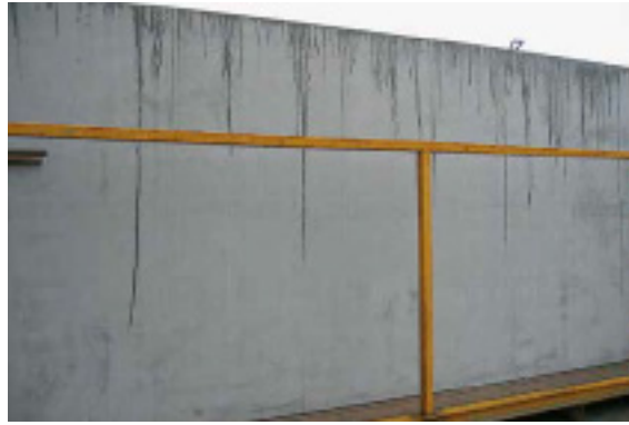
Abb. 5.4 Ungeschützte Lagerung: Wasserspuren
