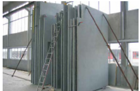
Abb. 5.5 Geschützte Lagerung in der Halle
