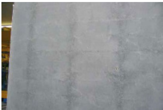
Rys. 5.3 Odciskanie się zbrojenia
