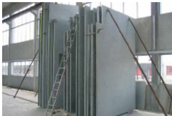
Obr. 5.5 Chránené skladovanie v hale
