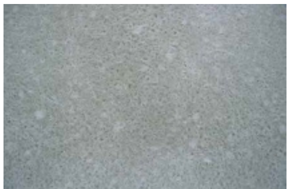
Fig. 5.2 Grov ballast avtecknar sig på ytan
