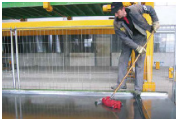
Fig. 4.2. Jämn fördelning utförd med trasa
